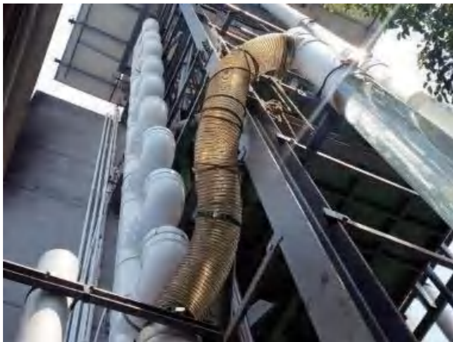
软管和阶梯式水管的组合形式
