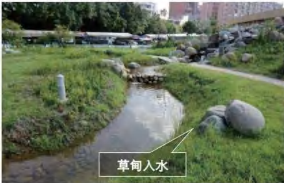
自然柔性堤岸：草甸入水堤岸
