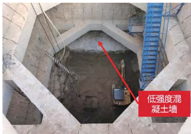
低强度混凝土墙现场图
