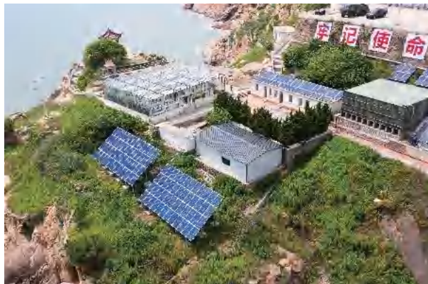
苏山岛风光互补海水淡化生活供水系统装备俯视图
