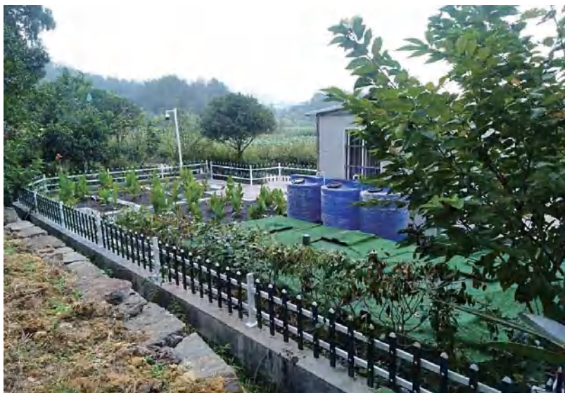
非常规水处理设施土建施工现场
