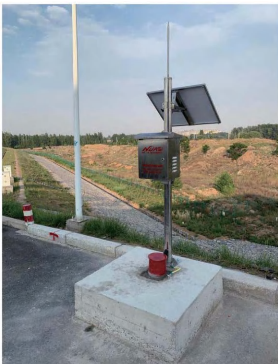
完成安装后的阵列式位移计
