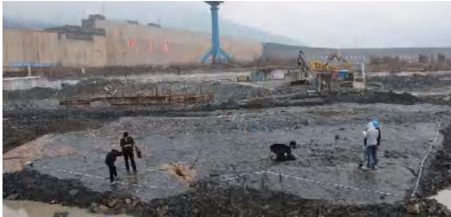
坝基岩体裂隙采集现场图
