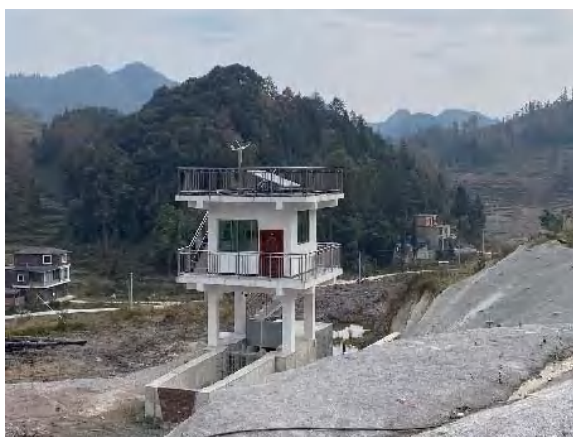
铸铁闸门螺旋杆启闭机采用风光互补供电系统整体照片 1
