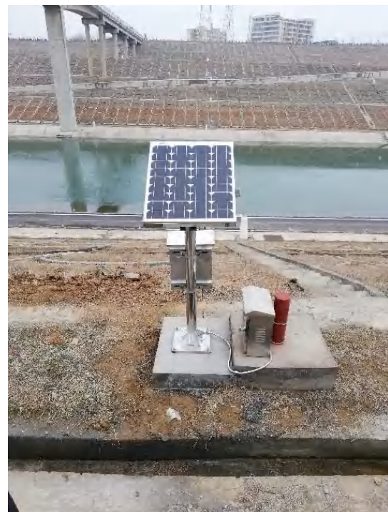
完成安装后的阵列式位移计
