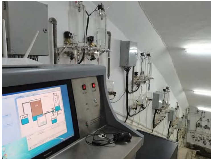
潜水蒸发室（建筑）1
