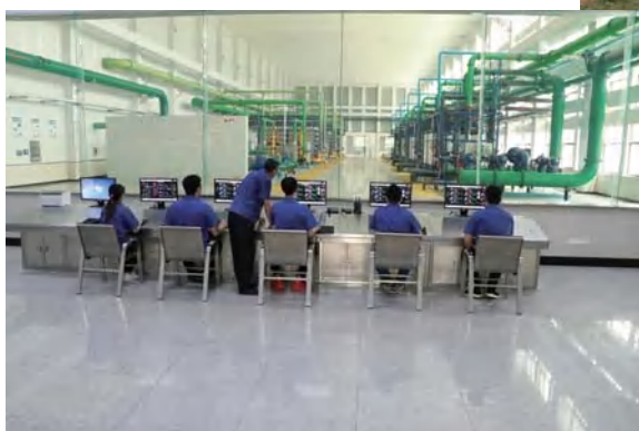
再生水深度处理利用示范工程
