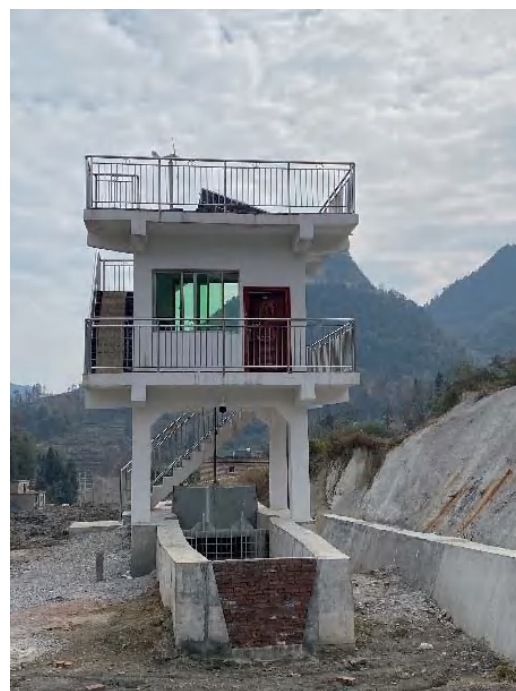
铸铁闸门螺旋杆启闭机采用风光互补供电系统整体照片 2
