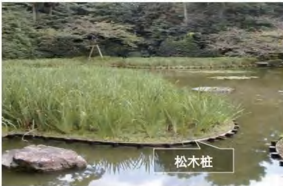
改造型柔性堤岸
