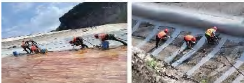
洪家渡水电站大坝面砼缺陷处理施工照片
