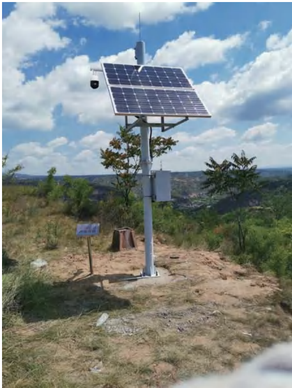
监控监测设备安装现场
