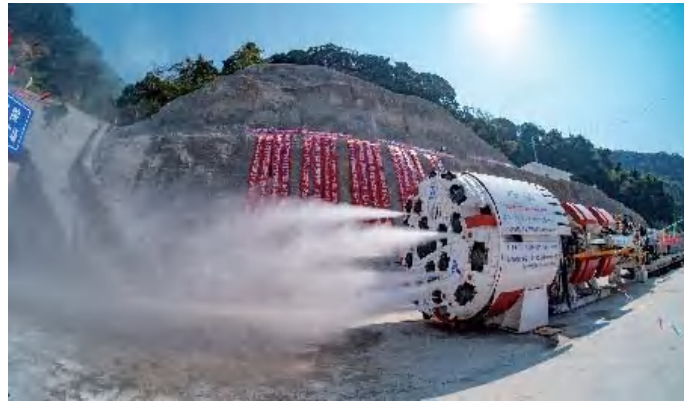
“龙岩号” TBM 试喷高压水
